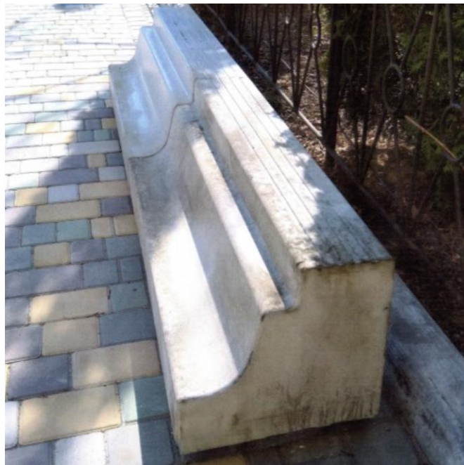
Рисунок 4.14 – Перший прототип Кассельського бордюру
